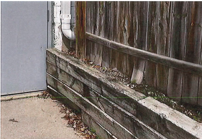
WOODEN RETNING WALL
