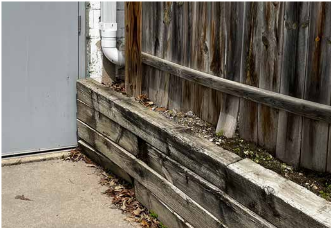
WOODEN RETNING WALL
