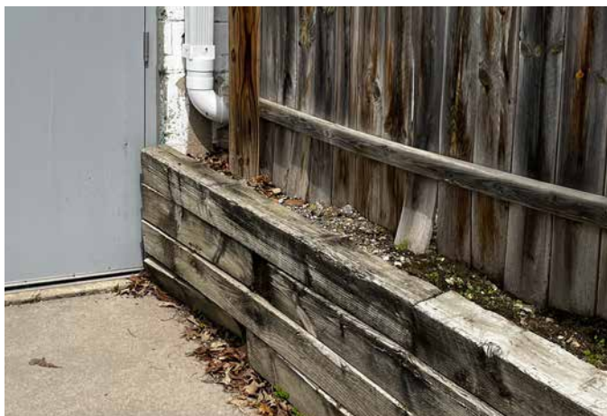
WOODEN RETNING WALL
